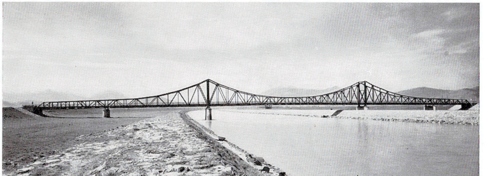
Brücke über den Diepolds- auer Durchstich.
